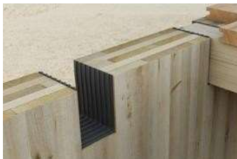
Imagen 25: Vista en sección Aladin Stripe Imagen 26: Modo de aplicación unión muro- muro Imagen 27: Modo de aplicación viga - muro
